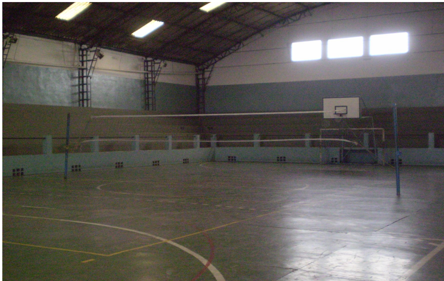
QUADRA DA UNIDADE ESCOLAR
