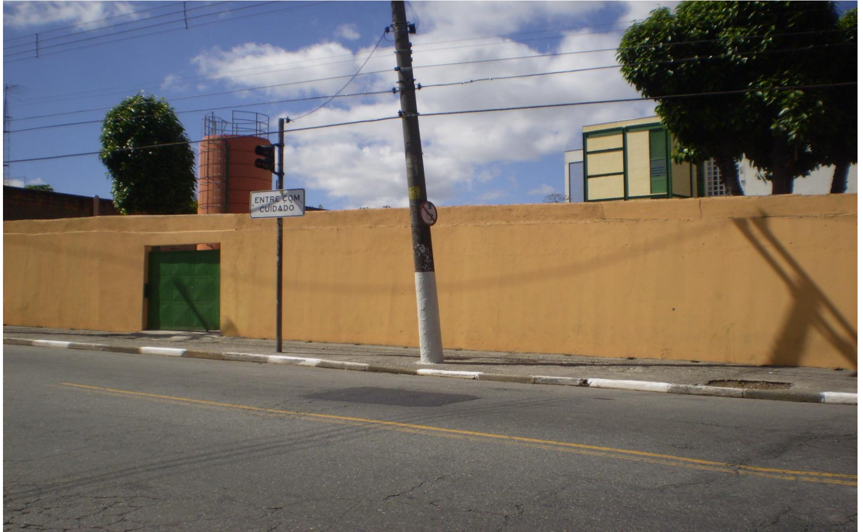
MURO DA UNIDADE ESCOLAR
