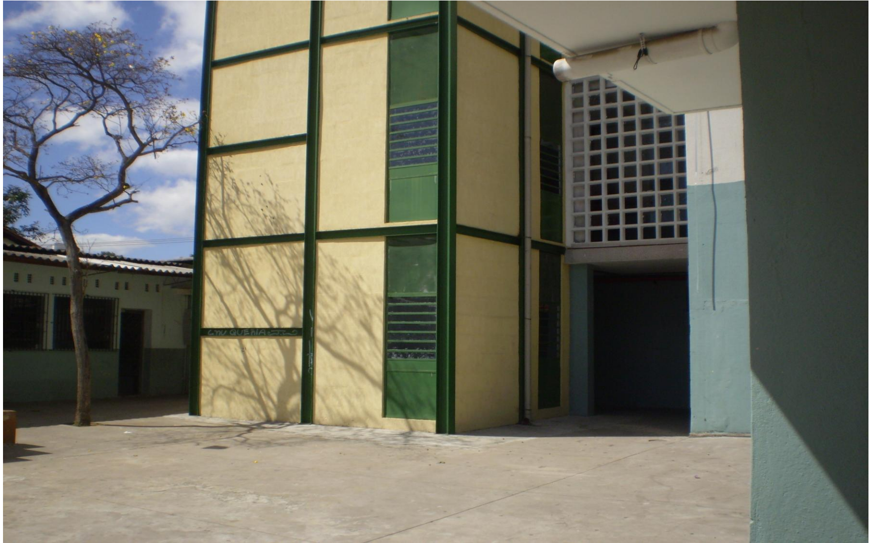
ELEVADOR DA UNIDADE ESCOLAR
