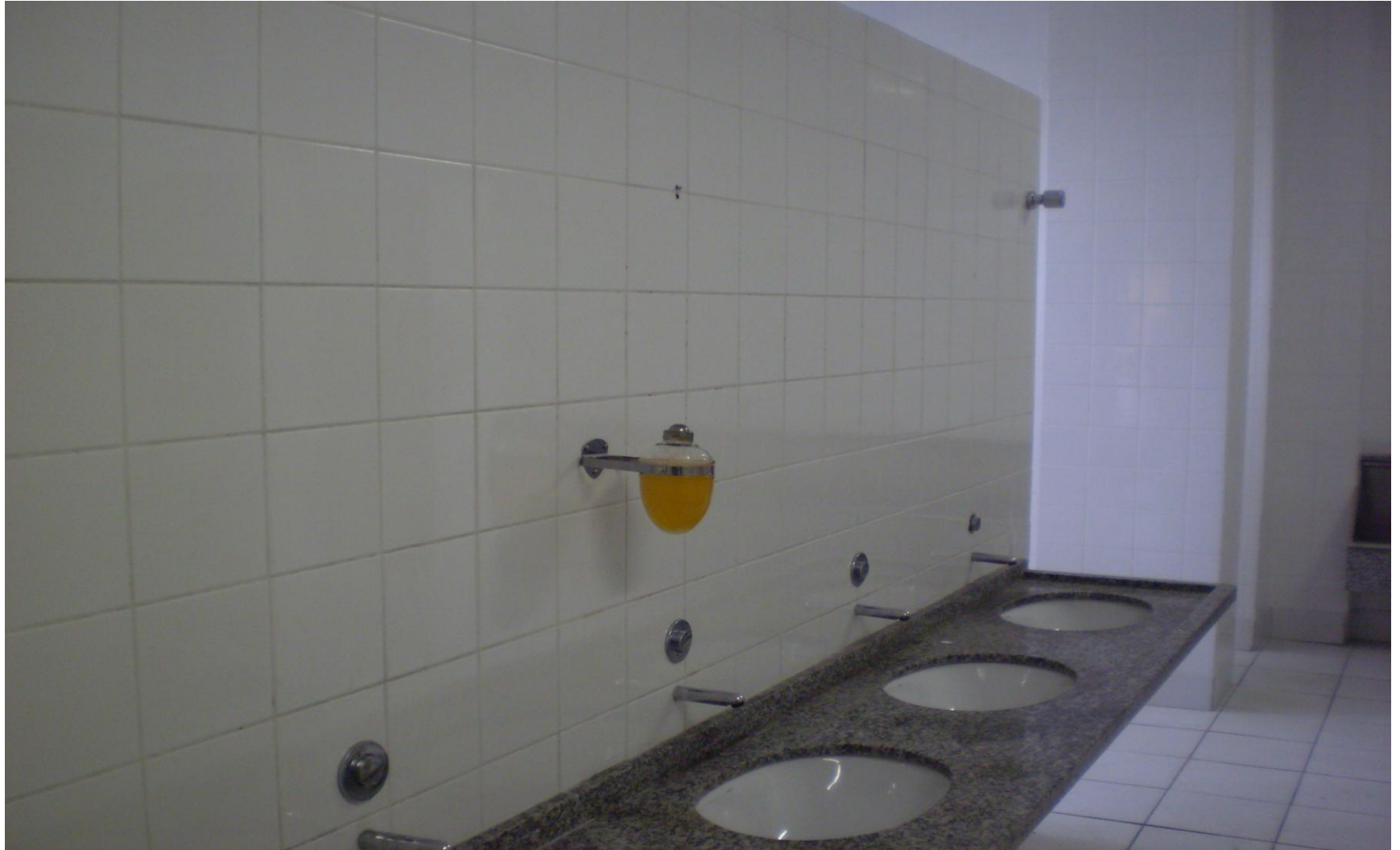
BANHEIRO DA UNIDADE ESCOLAR
